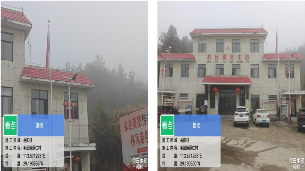
图 2.1.2-16 道仁村站现状
