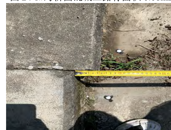
图 26 0#桥台下游侧错台 5cm
