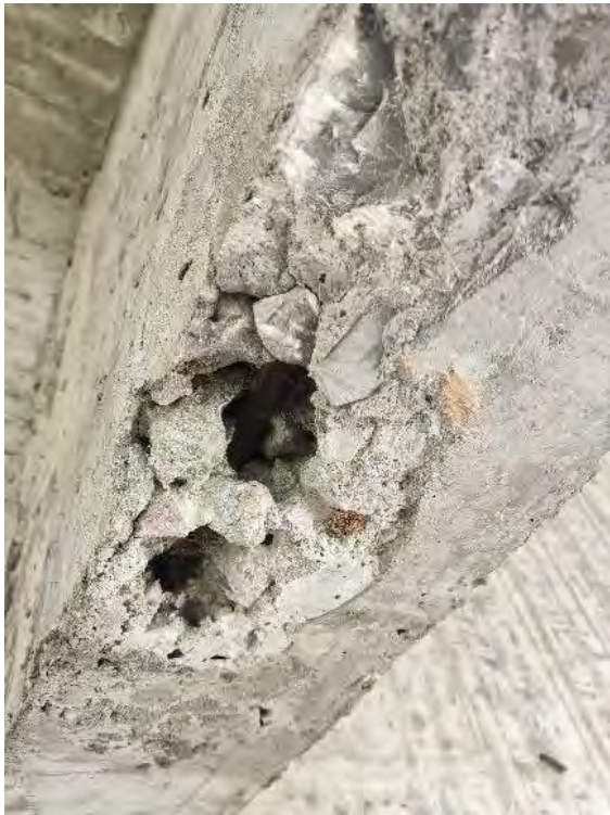
图 9 2-2#拱片和 2-3 拱片横系梁空洞 面积 0.525m²
