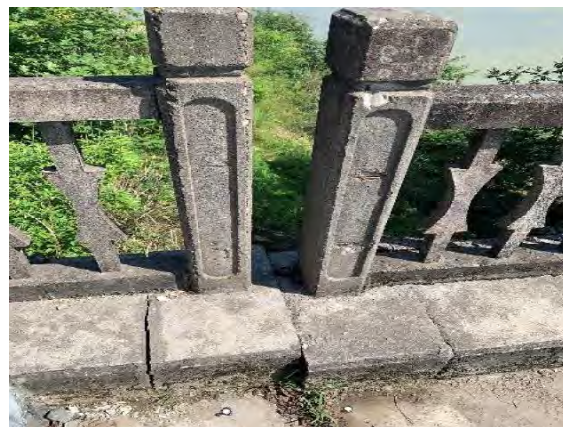
图 29 上游侧护栏承重柱锈胀露筋，下游侧护栏承重柱锈胀露筋
