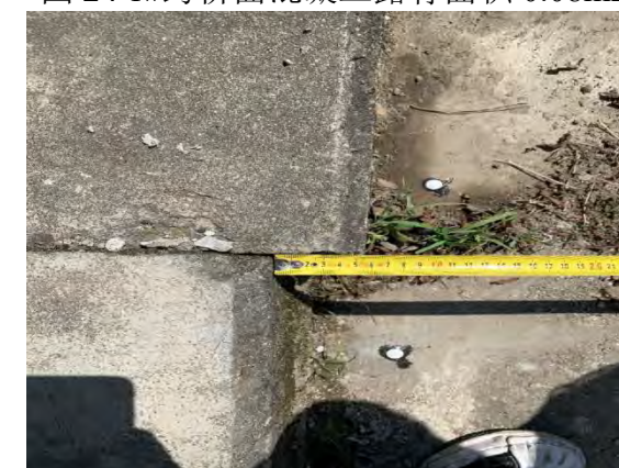
图 26 0#桥台下游侧错台 5cm
