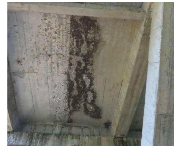
图 15 2-1#桥面板纵缝长 2.1m，宽 0.04mm
