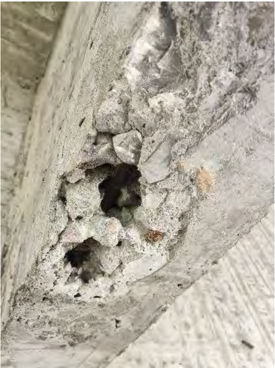
图 9 2-2#拱片和 2-3 拱片横系梁空洞 面积 0.525m²
