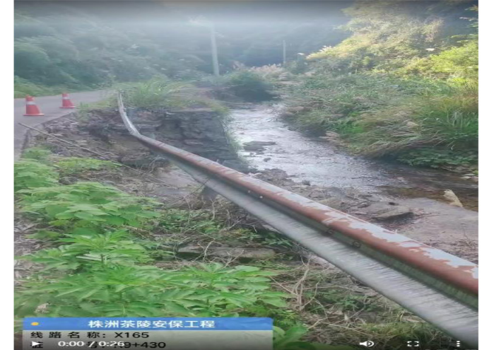
护栏原有挡墙缺失段拆除重建
