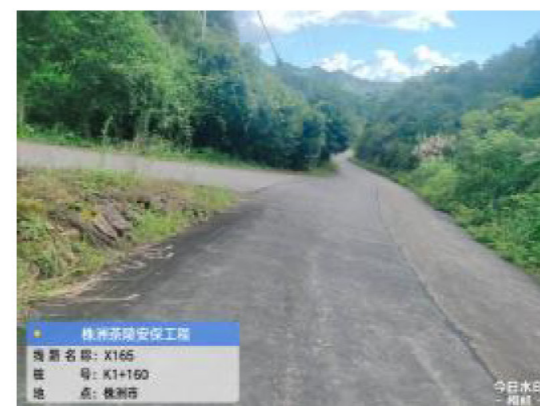
平交路口新增道口桩
