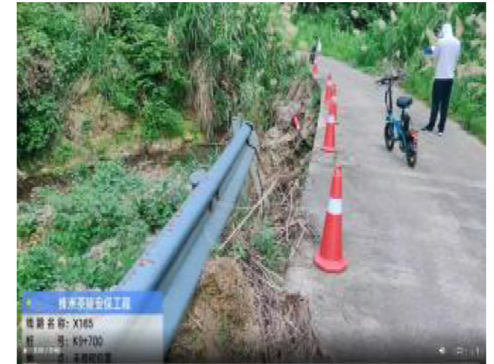
护栏损毁段拆除重建
