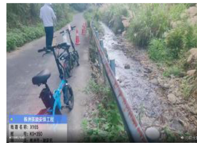
护栏基础缺失段拆除重建
