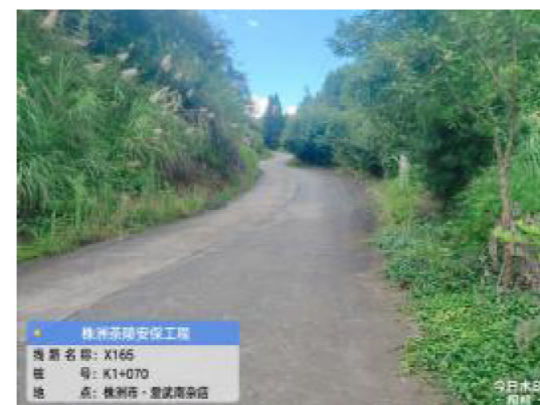
陡坡急弯段新增标志牌
