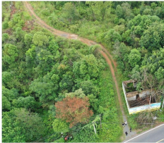
东富村蚂蝗塘组现状路面照片
