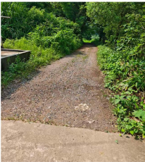
森冲村虎石坡至五口塘组道现状照片
