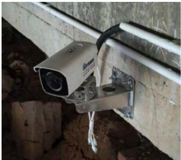
图 10.1 光电挠度仪设备图 5.2.3 桥面交通状况及视频抓拍
