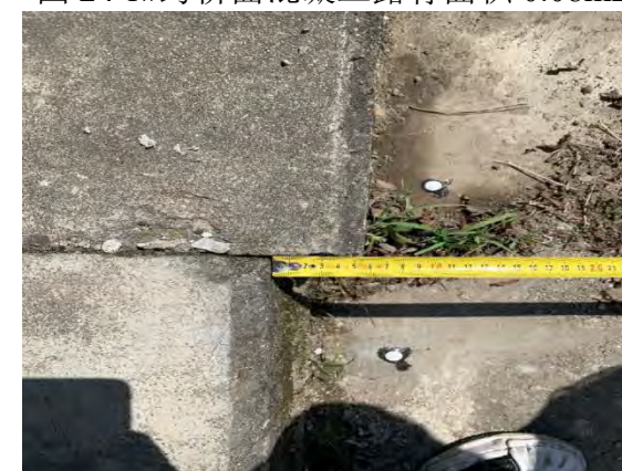
图 26 0#桥台下游侧错台 5cm
