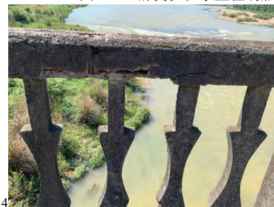
图 30 两侧护栏混凝土缺少，露筋，钢筋锈胀
